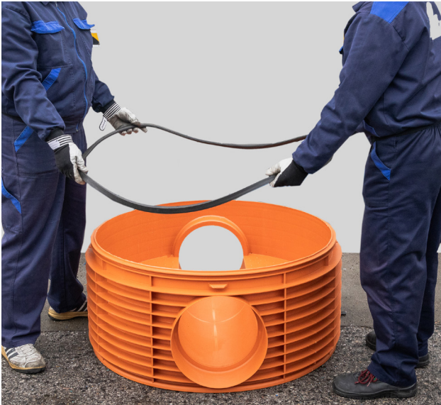
Првиот чекор е подмачкување на работ на базата за поставување на гумена заптивка
