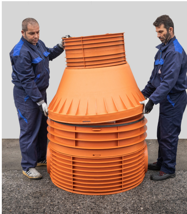
Подмачкување и подготовка за поставување на третата гумена заптивка; Монтажа на конусот
