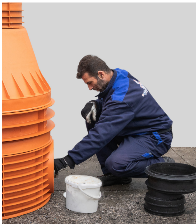
Подготовка за странично поврзување со приклучокот
